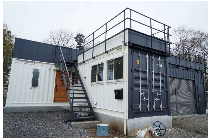
狭山コンテナガレージハウス
