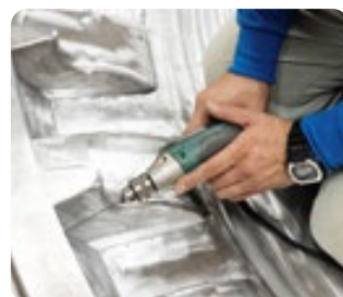
真っすぐに穴を開けるためには力加減の調節が重要。穴を開けるためのキリも技能員のお手製
