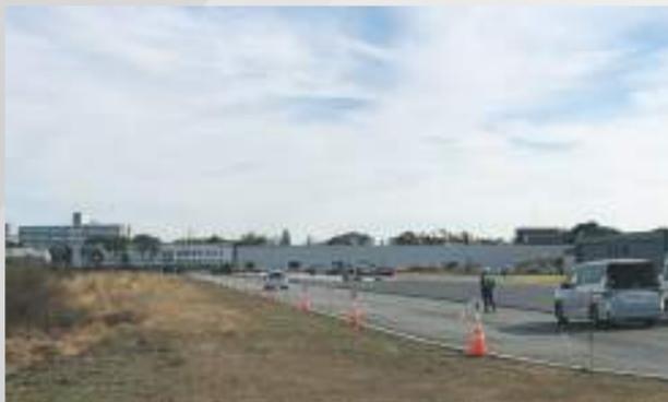
路面工事中の写真。一層目、二層の平坦性を官能評価している
